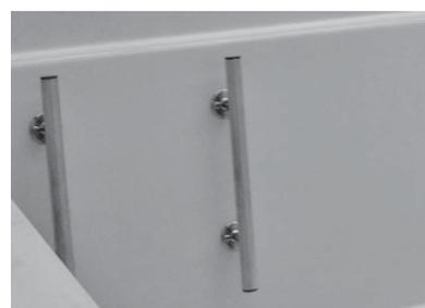
Wandverstreibungen sind besonders vorteilhaft bei Hallenbädern, die zu Revisions- und Installationszwecken mit einem Beckenumgang gebaut werden.
