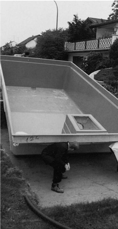
Unser Fahrer hat Rollwagen an Bord, mit denen das Becken über festen Untergrund geschoben werden kann. 5-6 Helfer sind erforderlich. Das Becken gleitet über 2 Gerüstbohlen in die Grube.
